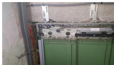
Serrure de porte palière du niveau principal
