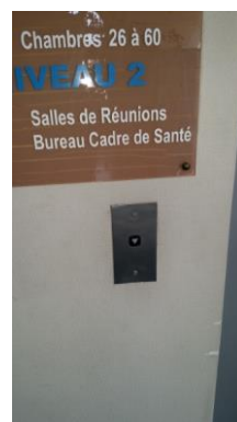
Commande palière du niveau principal
